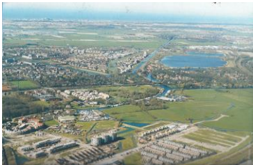
Afbeelding 9: De nieuwe wijk in aanbouw op een foto uit 2006
