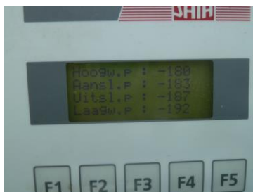
Afbeelding 29: De instellingen van het elektrische gemaal in de Klaas Hennepoelpolder
